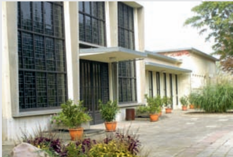
Zentralfriedhof Merseburg Große Feierhalle
